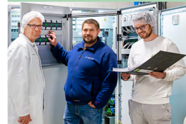
Projektleiter Martin Hartmann (Mitte) übergibt den Schaltschrank an den technischen Betriebsleiter Andreas Sepp (links) und den Produktionsleiter Martin Reischmann (rechts) von Allgäu Milch Käse eG
